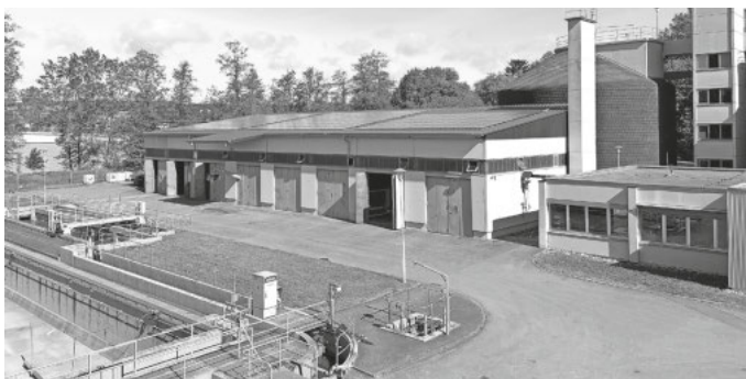
Blick auf die neue PV-Anlage im Klärwerk in Berg. Foto: F. Roth
