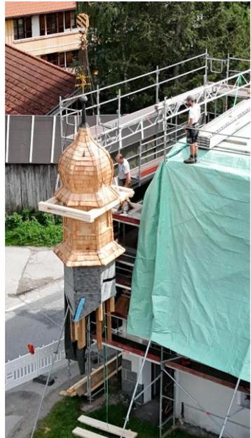
Die Maßnahmen umfassen eine Neueindeckung des Dachs mit Lärchenschindeln, die Erneuerung des Glockenturms sowie statische Verstärkungen im Dachstuhl. Damit wird die Kapelle dauerhaft gesichert und bleibt in ihrer ursprünglichen Schönheit erhalten.
