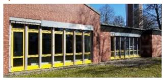
Im ersten Bauabschnitt der Pfarrheimrenovierung werden die Fenster, die viel an Raumwärme abstrahlen, ausgetauscht. Die Kosten für das Gewerk "Pfosten-Riegel-Fassaden und Fenster"
