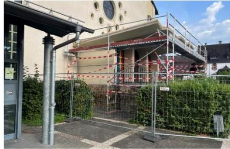
Mit der Reparatur des Schutzdachs und der neuen Abführung des anfallenden Regenwassers nach außen an die Kanalgrundleitung wurde zunächst die Ursache für die Schadensbildungen insbesondere in der Unterkirche beseitigt. So konnte die Sanierung vom Putz und die Erneuerung des Anstrichs im Vorraum von St. Josef und in der stark betroffenen Herrentoilette erfolgreich durchgeführt werden. Auch die Schmierereien an den Eingangstüren wurden entfernt und sie erhielten einen neuen Anstrich.
