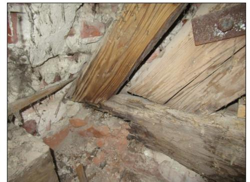
Fäulnisschäden im Dachtragwerk
