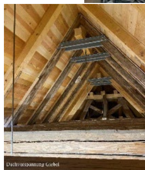
Dachstuhlspannung Giebel
