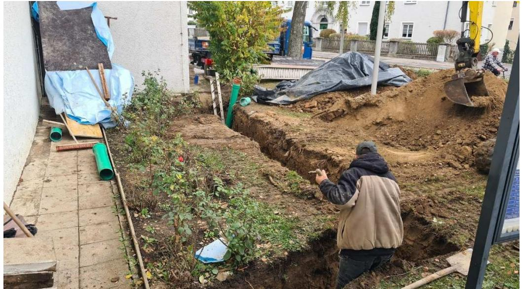
Die Maßnahme wurde angemeldet und erste Vorarbeiten wurden getätigt. Es wurden Mängel bei der Dachentwässerung und dadurch entstandene Schäden festgestellt. Im November haben die beauftragten Firmen einen ersten Teil der Notmaßnahmen zur Entwässerung durchgeführt, damit der Winter nicht größere Schäden anrichten kann. Allein die Maßnahmen in diesem Zusammenhang schlagen mit gut 80.000 € zu Buche, wobei wir von der Diözese eine Förderung über
