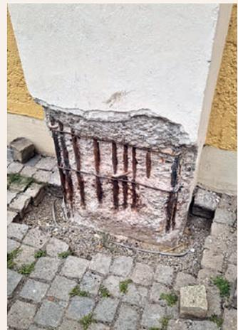
Fundamentschäden an den Säulen
