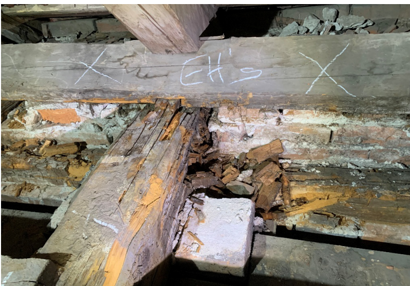
Dachstuhl der Pfarrkirche Wallersdorf: Feuchtigkeit und Hausschwamm haben dem Gebälk sichtbar zugesetzt.
